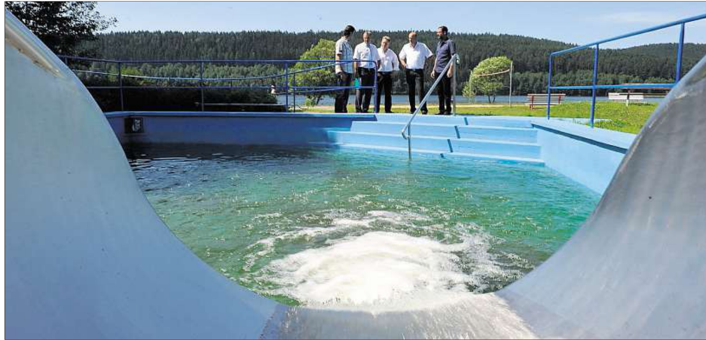
Die Riesenwasserrutsche ist die Attraktion im Erholungsgebiet Bergsee Ratscher. Dass sie auch bei niedrigen Stauhöhen reibungslos funktioniert, muss die Pumpenanlage für etwa 5000 Euro umgebaut werden. Dafür gibt es Lottomittel.
