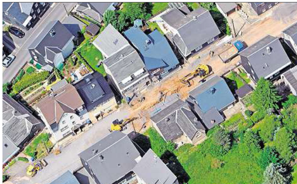
Noch präsentiert sich Steinheid als Baustelle. Bald soll die Straße als Umgehung genutzt werden.
