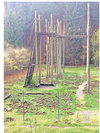
Auch am Hochseilgarten oberhalb des Sportplatzes ist der Boden aufgerissen.
